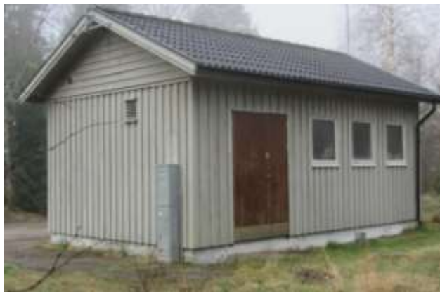
Vattenverk, foto "Allmänna tekniska verk"
